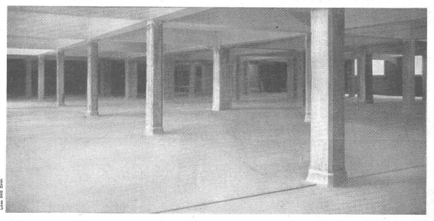
Ca. 600 m² wasserdichter Barra-Zementüberzug auf Kellerboden 6 m unter Strassen-Niveau
