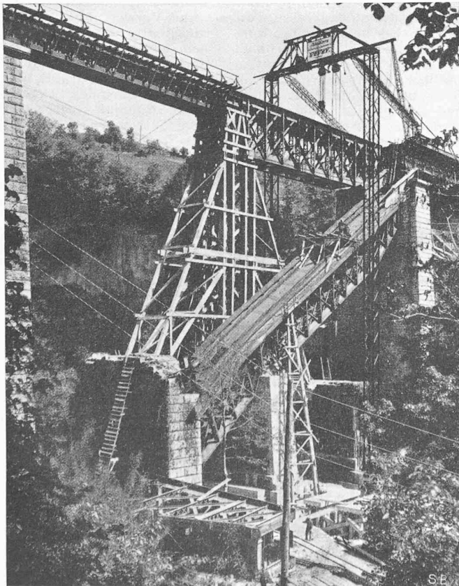
Bild 2. Beginn der Hebung des zweiten Trägers
