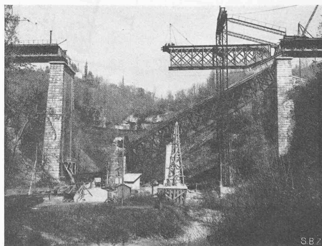
Bild 1. Pymont-Brücke, erste Phase der Wiederherstellung
