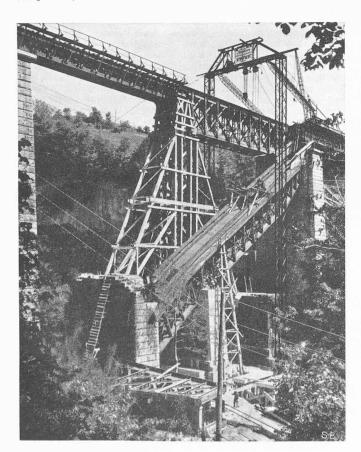
Bild 2. Beginn der Hebung des zweiten Trägers
