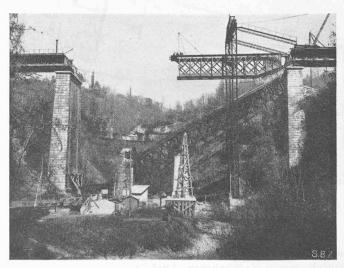
Bild 1. Pyrimont-Brücke, erste Phase der Wiederherstellung
