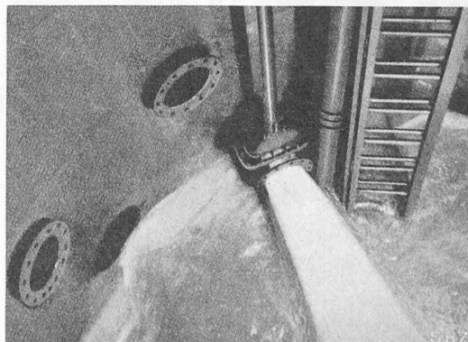
Bild 3. Spülen eines Fassungsrohres
