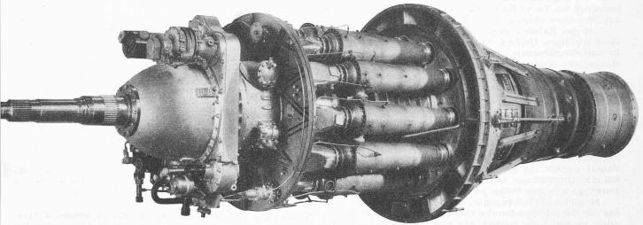
Bild 12. Propeller-Turbo-Triebwerk «Python» von Armstrong-Siddeley
