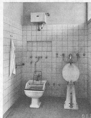
Bild 17. Ausguss und Steckbecken-Reiniger
