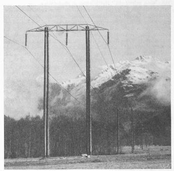
Bild 1. Tragjoch auf Holzmasten der Talstrecke im Oberwallis
