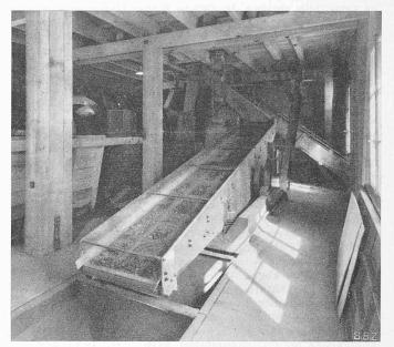
Bild 16. Trockensortierung: Exzentrisch gelagertes Rüttelsieb (11)
