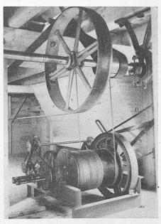
Bild 14. Kübelaufzugwinde (6)
