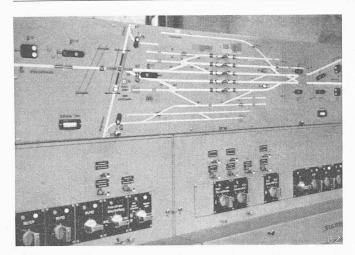
Stellwerkanlage in Suhr. Auf der Gleistafel ist links die Kreuzung mit der Wynentalbahn zu erkennen
