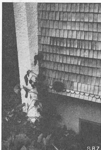
Bild 24. Anschluss der Schindelwand an die Mauer
