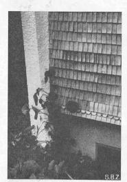
Bild 24. Anschluss der Schindelwand an die Mauer
