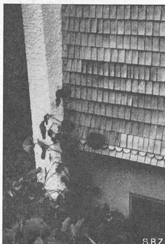
Bild 24. Anschluss der Schindelwand an die Mauer
