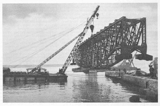
Bild 4. Versetzen der Kranbrücke mit Schwimmkran von 130 t Tragkraft
