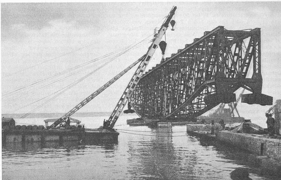
Bild 4. Versetzen der Kranbrücke mit Schwimmkran von 130 t Tragkraft
