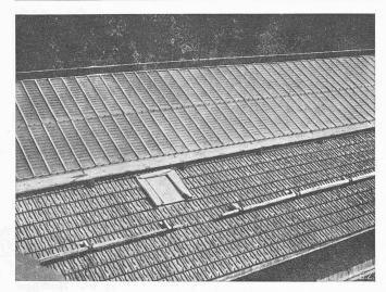
Bild 2. Wärmeaufnehmer des Sonnenwärmespeichers Sutter-Adank
