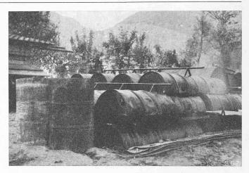
Bild 2. Zum Auffangen des Erdgases dienende Blechfasshälften, die durch Röhren miteinander verbunden sind
