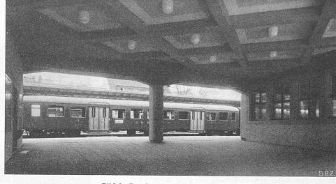
Bild 6. Durchgang mit Diagonalrost-Decke von  $10 \times 11$  m Spannweite
