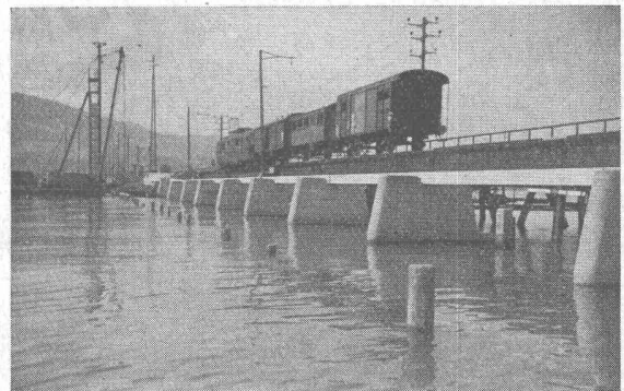
Pfeiler der Eisenbahnbrücke Rapperswil-Hurden
