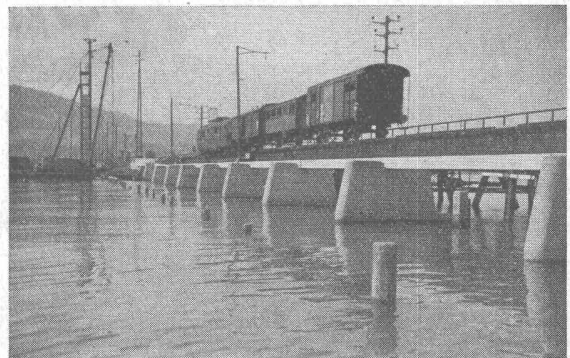
Pfeiler der Eisenbahnbrücke Rapperswil-Hurden
