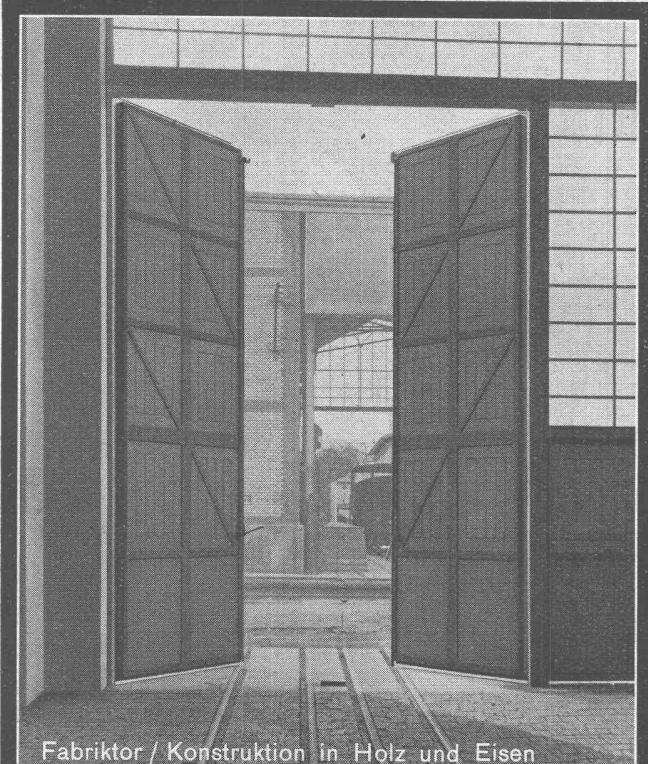
Fabriktor / Konstruktion in Holz und Eisen
