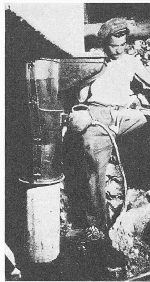
Bilder 16 bis 18. Armierung, Betonieren (Vibrieren) und fertige Pfahlköpfe beim Rihour-Palast
