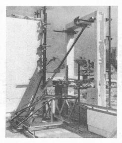
Bild 3. Montage eines Fenstergewändes
