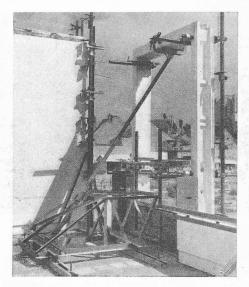
Bild 3. Montage eines Fenstergewändes
