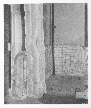
Bild 5. Montage des Schallschluckmaterials auf die Pavatexplatten
