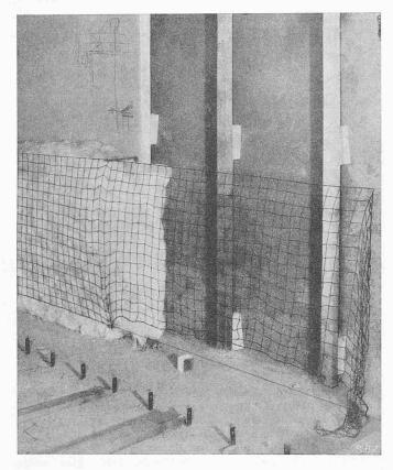
Bild 8. Lattung mit Unterlage, Pavatexplatte und Hohlraum?
