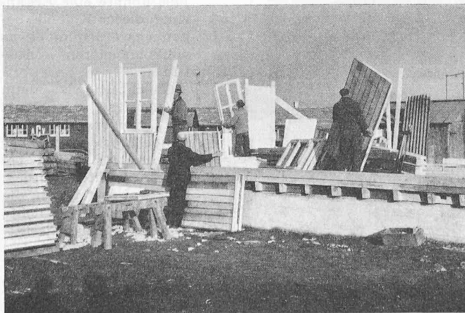
Bild 8. Montage-Zustand um 9 h
