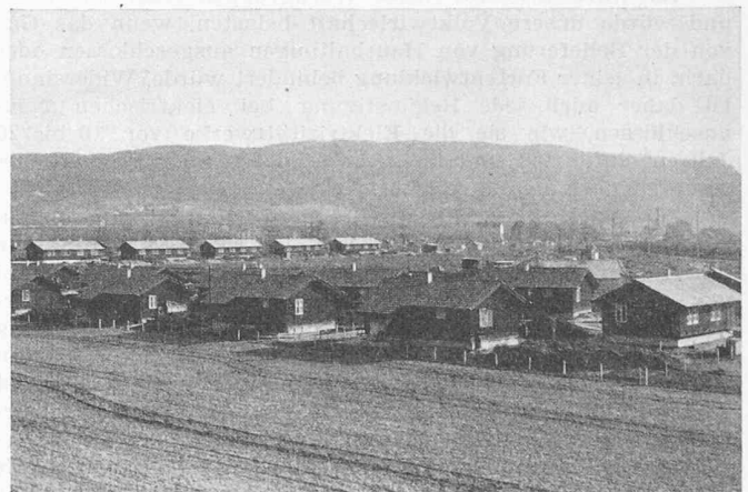
Bild 11. Die Siedlung «Im Landauer» von Südwesten
