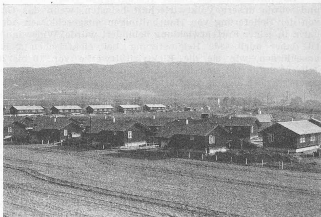
Bild 11. Die Siedlung «Im Landauer» von Südwesten
