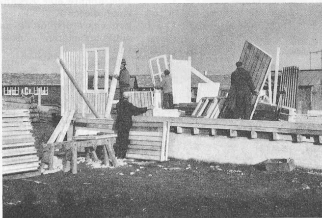
Bild 8. Montage-Zustand um 9 h
