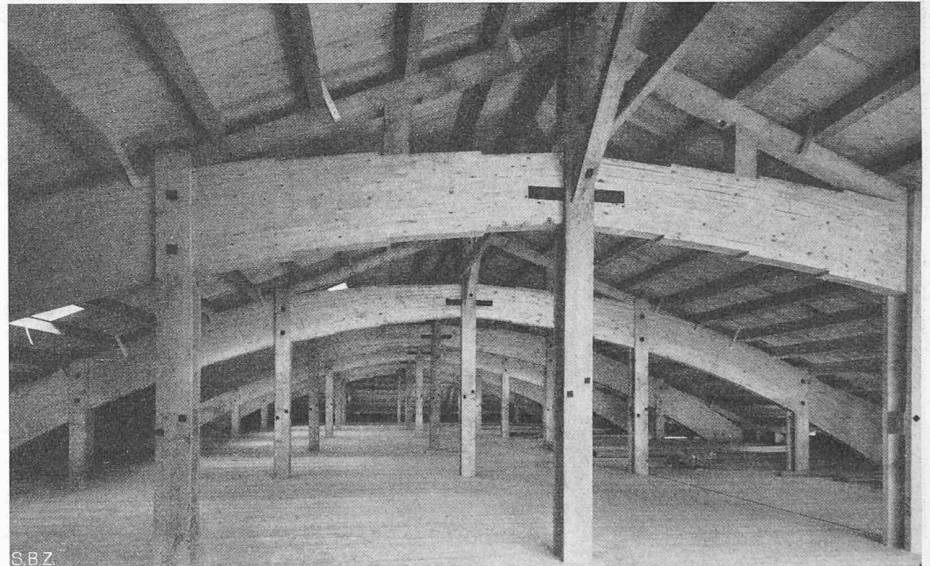
Bild 16. Dachboden des Neubaus an der Laufengasse der S. I. G., Neuhausen am Rheinfall
