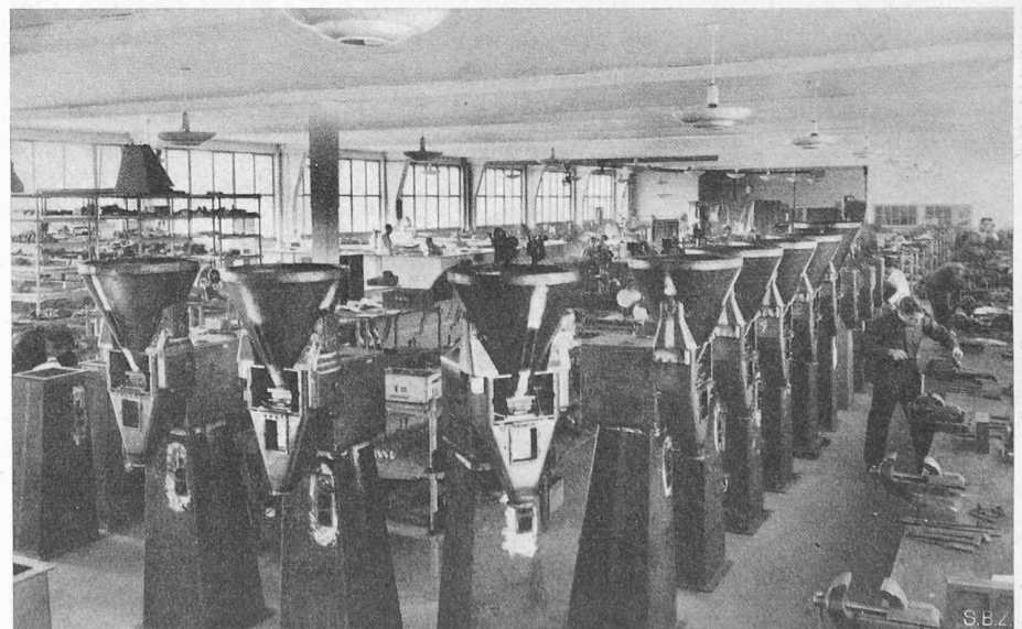
Bild 17. Dritter Stock, Detail-Schlosserei (im Vordergrund Montage von Abfüllmaschinen)
