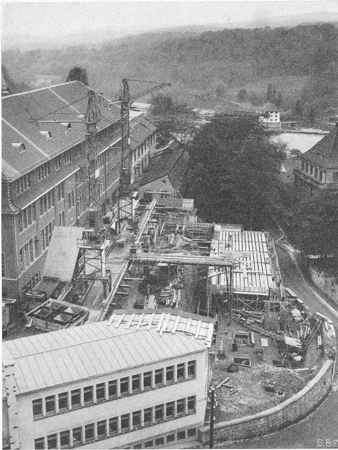
Bild 6. Die Baustelle aus Osten (Anfangstadium)
