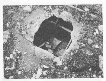
Bild 4. Durchschlag in der obern Decke, Loch rd. 0,2 m Ø
