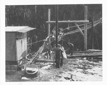
Bild 6. Antriebstation Schallberg an der Simplonstrasse mit wegen Platzmangel rechtwinklig abgedrehter Maschine
