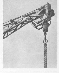
Bild 2 (rechts). Hub-Endschalter an der Auslegerspitze eines Baukrans
