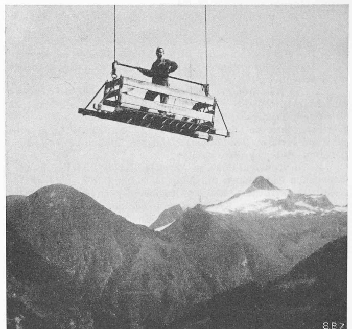
Bild 5. Für Personentransport eingerichtete Kranbrücke, Hubhöhe 60 m
