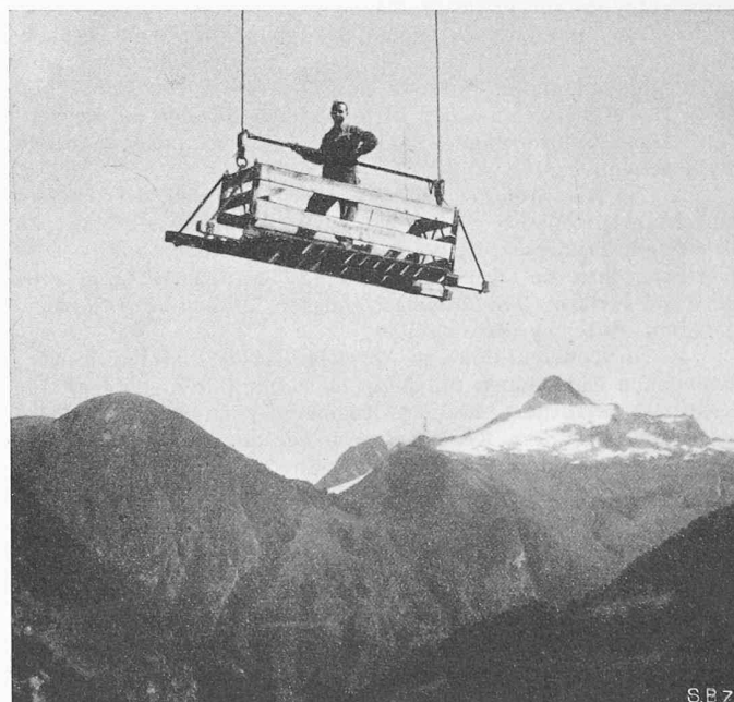
Bild 5. Für Personentransport eingerichtete Kranbrücke, Hubhöhe 60 m
