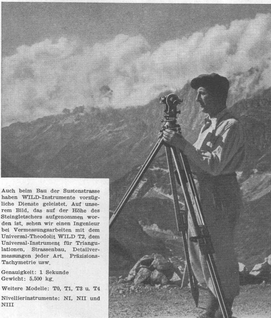
Auch beim Bau der Sustenstrasse haben WILD-Instrumente vorzügliche Dienste geleistet. Auf unserem Bild, das auf der Höhe des Steingletschers aufgenommen worden ist, sehen wir einen Ingenieur bei Vermessungsarbeiten mit dem Universal-Theodolit WILD T2, dem Universal-Instrument für Triangulationen, Strassenbau, Detailvermessungen jeder Art, Präzisions-Tachymetrie usw.
