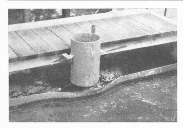
Bild 10. Dosiergefäss über der Einlaufrinne zum Vorklärbecken
