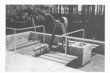
Bild 7. Schwimmdeckenzerstörer mit Handantrieb
