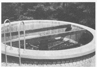
Bild 9. Selbstdrehender vierarmiger Sprinkler zur gleichmässigen Verteilung des mechanisch gereinigten Abwassers auf dem Tropfkörper
