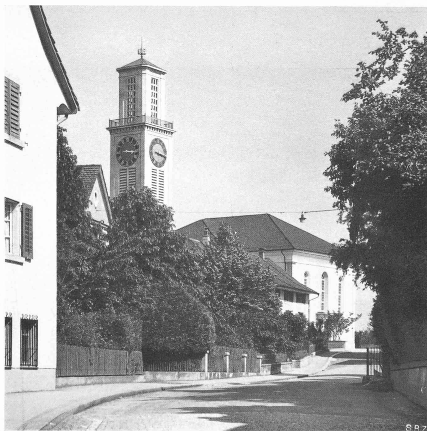
Die wiederaufgebaute Kirche in Thalwil, oben aus Süden, unten aus Nordwesten
