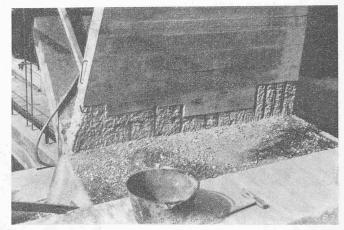
Bild 6. Freigelegte Armierungseisen
