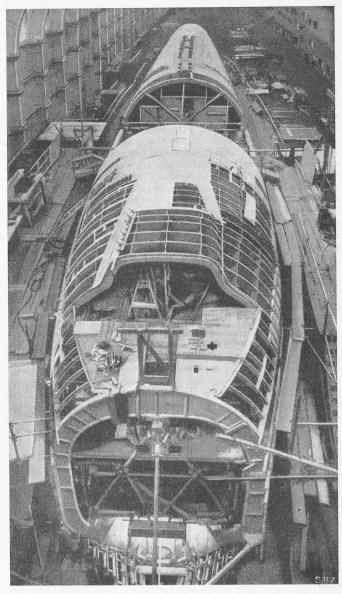
Bild 1. Der Rumpf des «Hercules» beim Zusammenbau
