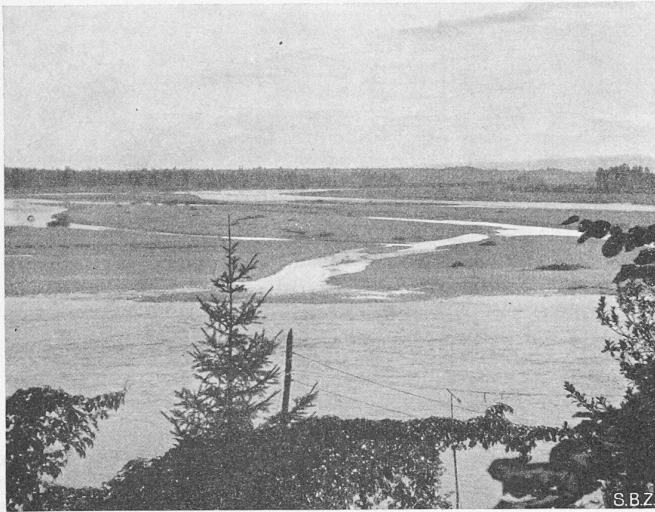
Bild 1. Einmündung des Ain in die Rhone, gegenüber Anthon (Staugebiet des Kraftwerks Jonage)
