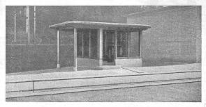
50t Geleisewaage mit armierter Betonbrücke, torsionsfreien Hebeln und verstellbaren Schneiden
