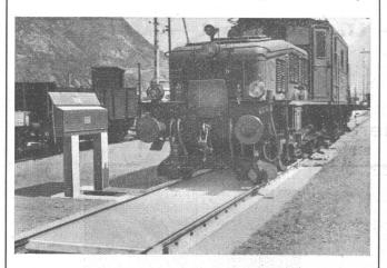
Kein Unterhalt der Brücke, wassergeschütztes Unterwerk
