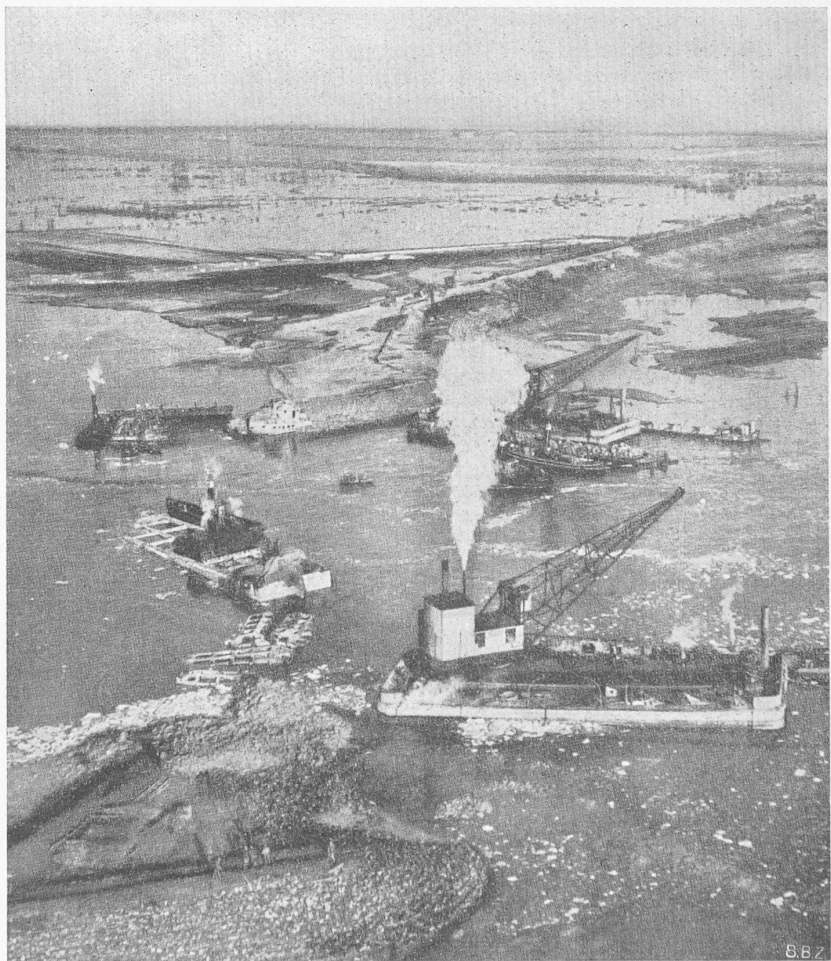
Walcheren. Schliessung der vierten (im Text nicht behandelten) Lücke bei Rammekens (östlich von Vlissingen) nach «De Ingenieur» vom 19. 4. 46
