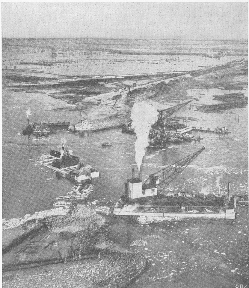
Walcheren. Schliessung der vierten (im Text nicht behandelten) Lücke bei Rammekens (östlich von Vlissingen) nach «De Ingenieur» vom 19. 4. 46
