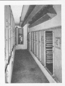
Bild 10. Bedienungsgang mit Luftkühler im Obergeschoss, rechts ein Feld der Verschalung offen
