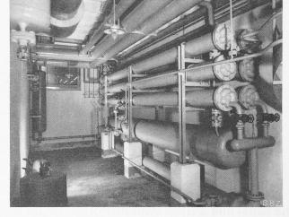
Bild 6. Stapelraum für gefrorenes Fleisch mit Kühlröhren für Bild 7. Kellergeschoss des Maschinenhauses mit Röhrenkessel-Koninnere Ammoniakverdampfung densator, aufgebaut aus 6 Elementen, darunter Sammler, hinten links wassergekühlter Oelabscheider
