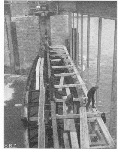
Bild 20. Dammbalken in Oeffnung 1 während der Aufschtiftung der Spundwandführung. Ablassen in die volle Strömung mit Flaschenzügen und über den Nischen aufgestellten Winden
