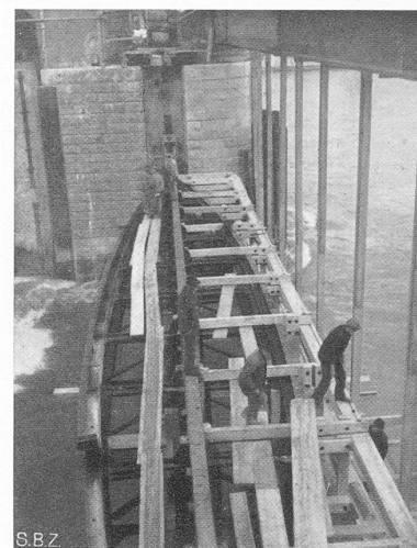
Bild 20. Dammbalken in Öffnung 1 während der Aufschriftung der Spundwandführung. Ablassen in die volle Strömung mit Flaschenzügen und über den Nischen aufgestellten Winden
