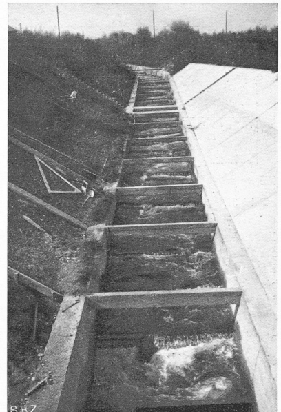
Bild 31. Strömung im Fischpass
