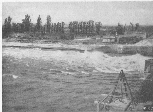
Bild 18. Abflussbild bei 500 m 3 /s durch Oeffnung 5; rasche Beruhigung des Abflusses; Entwicklung starker Quer-Dünung. 16. Mai 1946
