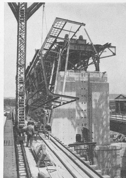
Bild 12. Beschleunigte Montage des Windenhauses über Öffnung 4. Windenhaus aus Alt-Material
