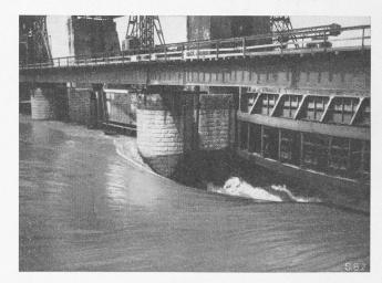
Bild 14. Einströmen von 1100 m³/s Wasser in Oeffnung 5 am 14. Juni 1946; starke Kontraktion bei Pfeiler IV infolge Querströmung längs der geschlossenen Schütze 4. Das Bild zeigt die wieder instand gestellte untere Schütze 5
