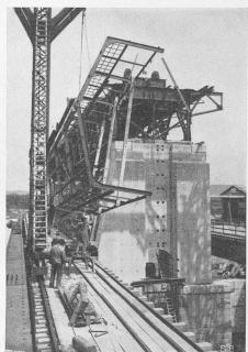
Bild 12. Beschleunigte Montage des Windenhauses über Oeffnung 4. Windenhaus aus Alt-Material
