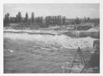
Bild 18. Abflussbild bei 500 m³/s durch Oeffnung 5; rasche Beruhigung des Abflusses; Entwicklung starker Quer-Dünung. 16. Mai 1946
