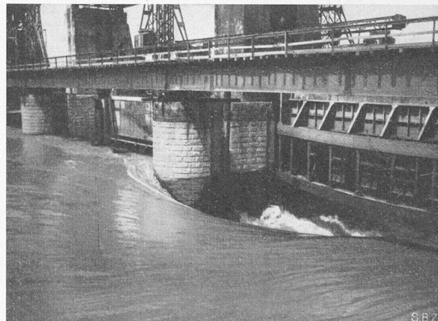
Bild 14. Einströmen von 1100 m³/s Wasser in Öffnung 5 am 14. Juni 1946; starke Kontraktion bei Pfeiler IV infolge Querströmung längs der geschlossenen Schütze 4. Das Bild zeigt die wieder instand gestellte untere Schütze 5
