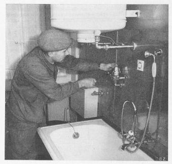
Bild 3. Isolierung der Leitungen
