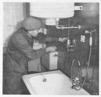
Bild 3. Isolierung der Leitungen
