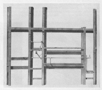
Bild 2. «Norma»-Block, Gestell mit Leitungen. Badseite
