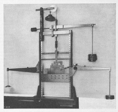
Bild 5. Versuchsanordnung. Oberer Hebel für die vertikale Druckkraft  $G_M$ Die Gewichte links oben dienen zum Gewichtsausgleich der Eigengewichte des Hebels und des Druckstempels
