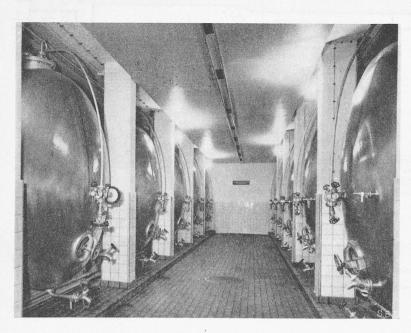
Bild°,18 (links). Lagerkeller mit Obstsafttanks f'des Aluminiumschweisswerkes Schlieren. An der Decke Rückluftkanal aus Pavatex mit Absaugeöffnungen
