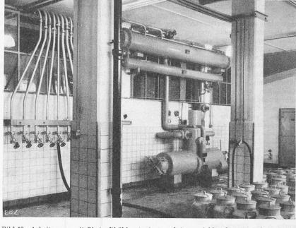
Bild 16. Arbeitsraum mit Obstsaftkühler (unten) und Ammoniakkondensator (oben), vorn (links) Abfüllstation
