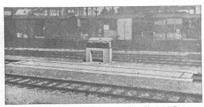
Brückenwaage für Geleiselahrzeuge, Wiegefähigkeit 70 T Betonbrücke in Rippenkonstruktion. Leichtbauart Giroud, 11,6 m l. Befahrbar für Lokomotiven bis 120 Tonnen Gewicht
