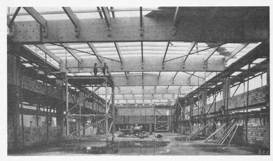
Bild 8. Rohbau. Man beachte die Dachkonstruktion aus Holz
