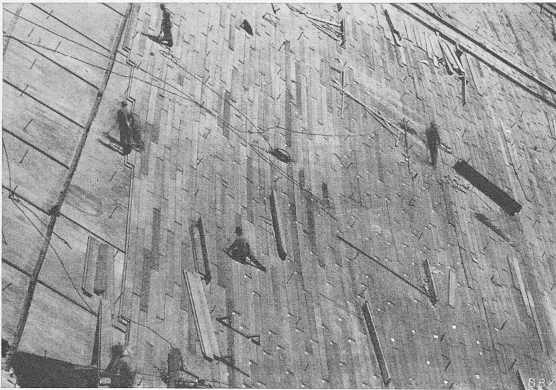
Bild 6. Verlegen der «Wakefield»-Bohlen in fertigen Einheiten mit 10 cm Längsfugen und 1 cm Querfugen
