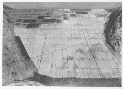
Bild 5. San Gabriel Damm Nr. 2 nach dem Hochwasser von 1933; Betonplatten-Decke zerstört, Damm zusammengesackt
