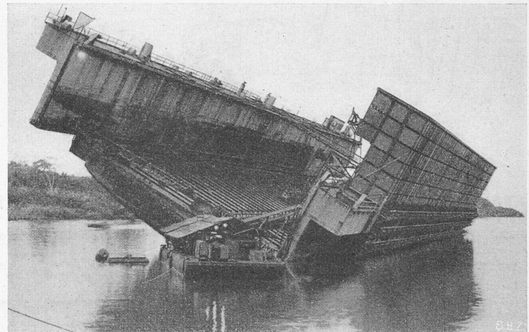
Bild 5. Das Dock wird in Hochkant-Stellung gebracht
