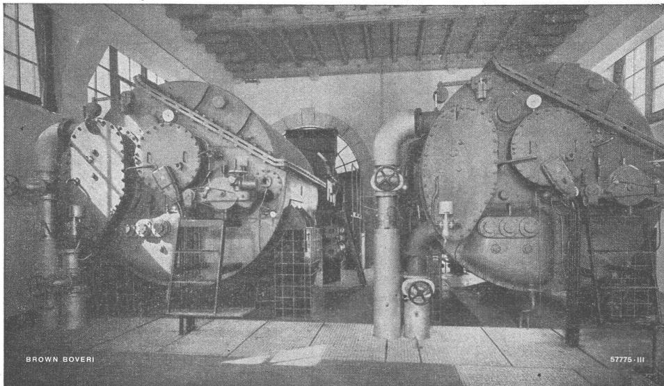
Wärmepumpenanlage einer Schweizer Kunstseidenfabrik; zwei Brown Boveri Thermoblocs mit einer Heizleistung von je 1,0 bis 1,7 Millionen kcal/h. — Jährliche Kohlenerspartniss 2×2100 Tonnen.
