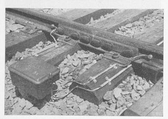
$\operatorname{Bild}$  5. Isolierstoss mit Anschlussleitungen für die Gleisströme zur Ueberwachung der Gleisbelegung
