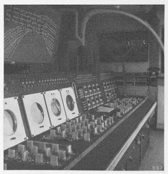
Bild 9. Stellwerk im Bahnhof Bern-PB, das modernste im Netz der SBB. Unten Vierreihen-Schalterwerk, darüber Gleistafel, hinten Fahrschautafel auf der Westseite
