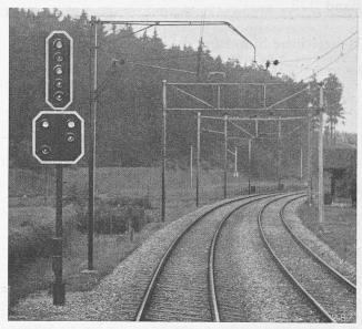
Bild 3. Normalisiertes vierbegriffiges Lichttages-Einfahrsignal (oben). 1 rotes Licht (zweitoberste Laterne) = Halt
