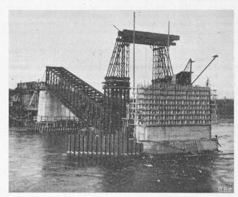
Bild 25. Pfeiler 4 und Oeffnung IV mit Hubvorrichtung
